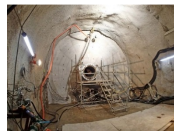
再冠水試験用止水壁の設置状況
