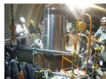
模擬オーバーパックの設置状況
