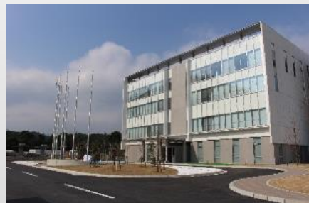
楢葉遠隔技術開発センター ・研究管理棟(H27/9/24～) ・試験棟(H28/2～)
